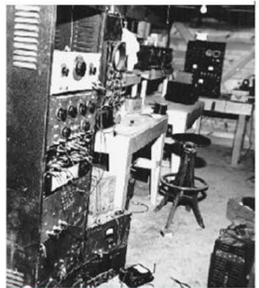
Рис.5 Радиооборудование главного бункера
